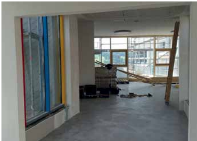
Blick auf den Gang des neuen Obergeschosses
