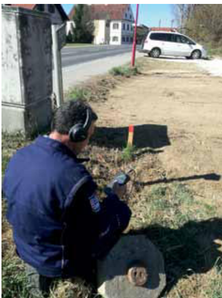
Leckortungen in der Wasserleitung mit Schallmessgerät.
