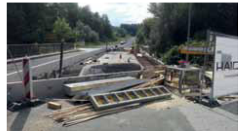
Brückensanierung Obergroßau durch das Land Steiermark.
