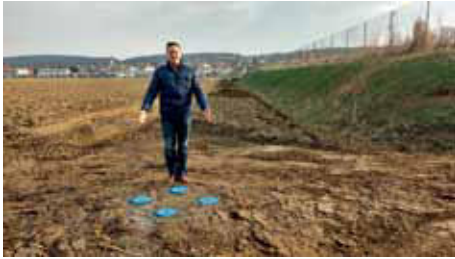
Aufschließung des Industriegebiets Mitte.
