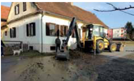
Behebung Wasserrohrbruch beim Hickl-Haus, Mitte März.
