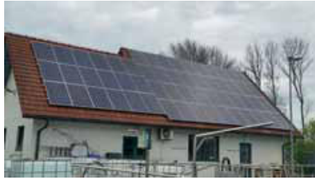
Solaranlage auf Dach der Kläranlage.
