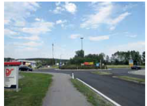
Neue Asphaltdecke im Kreisverkehr Untergroßau.
