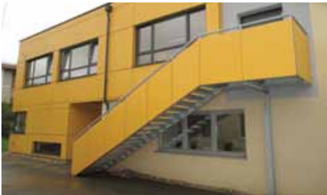
Neu errichtete Notstiege für den Kindergarten
