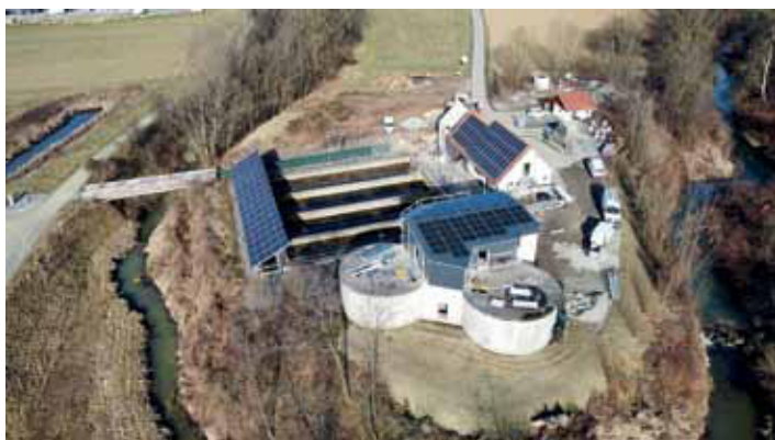
Erweiterung der Kläranlage
