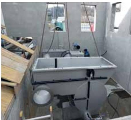
Im selben Atemzug wurde die Klärschlammpresse geliefert und in der Entwässerungshalle aufgestellt. Im nächsten Schritt wird nun der Dachstuhl des neuen Gebäudeteiles errichtet bzw. eingedeckt und die neuen Anlagen angeschlossen und in die Steuerung eingebunden. Wir halten Sie am Laufenden!
