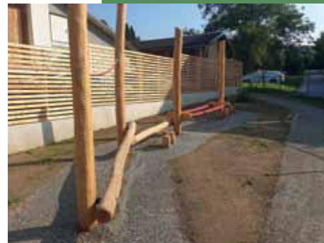
Die Außenanlage für den Kindergarten Sinabelkirchen wurde komplett erneuert.
