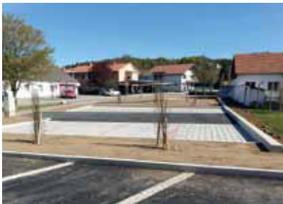
Errichtung eines kleinen Parkes und von Parkplätzen beim ehemaligen Berghold-Haus im ersten Lockdown.
