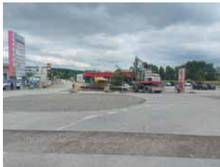
Der neue Kreisverkehr im Gewerbepark Untergroßau wurde errichtet.
